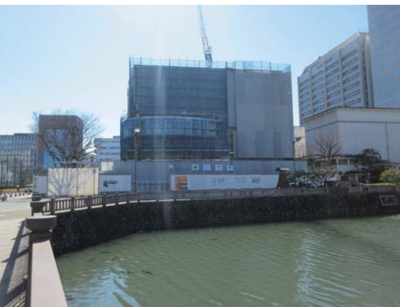
▲現在、建設中の博物館
