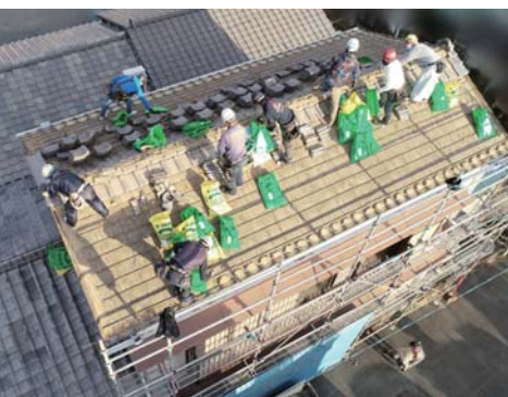
▲瓦葺き替え工事
