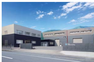
2016年に完成した新社屋・工場
