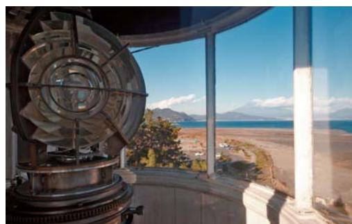
海面から21mの高さに設置され、26km先まで光を届けるレンズ
