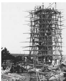
建設中の清水灯台（明治44年9月5日） 「ふるさとの思い出写真集・清水」より
