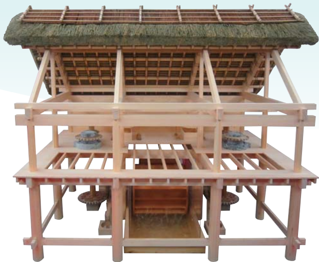
静岡で製作した1/5サイズの「水磨様」復元模型 高さ1700mm×幅1800mm×奥行1250mm
