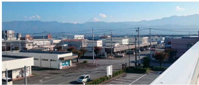
●山梨県最大の物流拠点として64社が入居している
